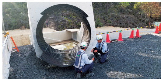
タブレットを現場で操作
